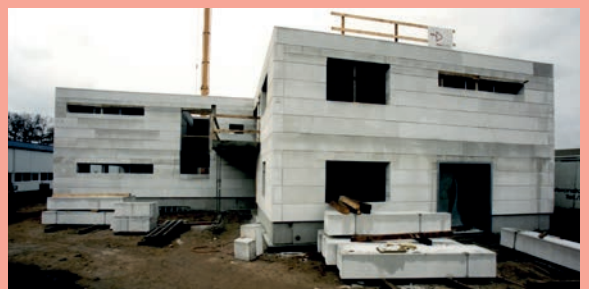
Das BdV-Gebäude in Henstedt-Ulzburg wird gebaut
